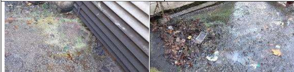
Detalle del purgado de los compresores a la solera exterior
